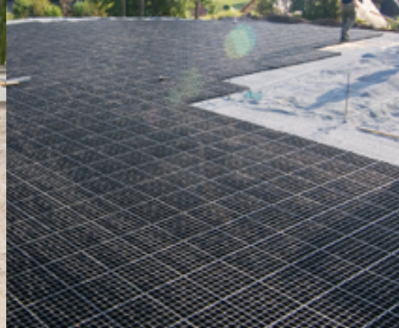
Großer Auslauf im Kreis verlegt
