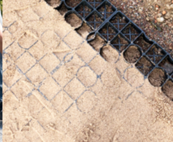
ProGrid mit Sand verfüllt
