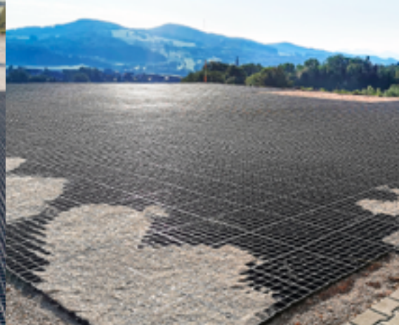
Fertig verlegte ProGrid
