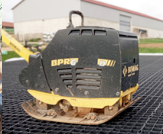
Abrütteln vor der Verfüllung
