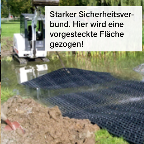
Befestigung einer Wasserdurchfahrt
