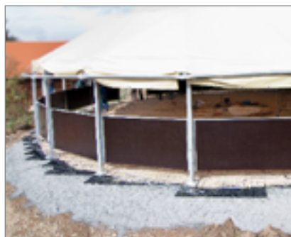
Longierzirkel mit Unterbau: Erdaushub befüllt mit 20 cm Schotter + 2 cm Splitt + ProGrid RG30
