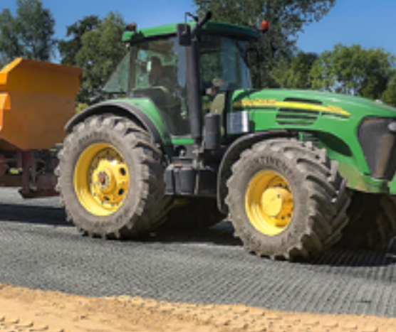
Maschineneinsatz auf der Fläche
