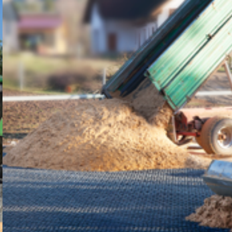
Anlieferung des Füllmaterials
