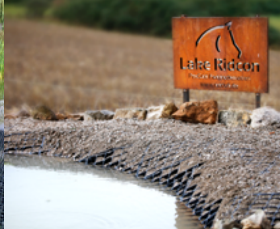
Befestigung eines Teiches
