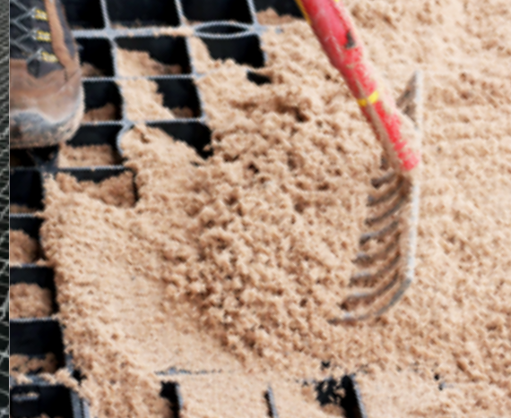
Verfüllen der Gitter
