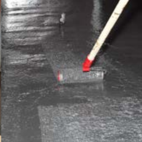
Glätten und Luftblasen entfernen
