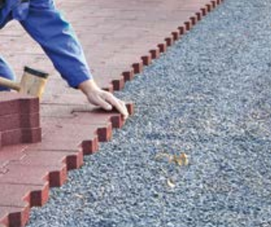
Verlegung auf Splittbett
