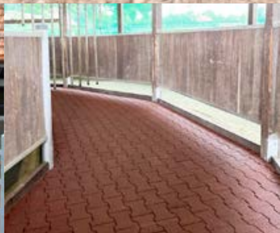
Einsatz in der Föhranlage
