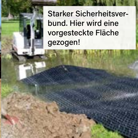
Befestigung einer Wasserdurchfahrt
