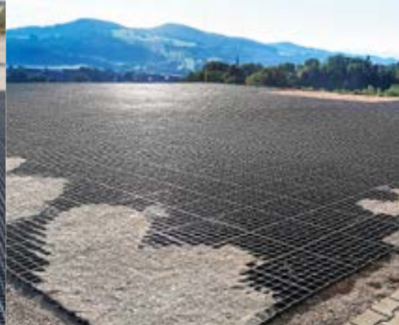
Fertig verlegte ProGrid
