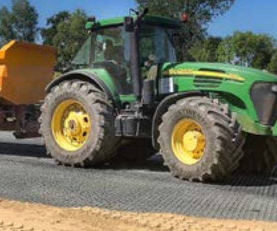
Maschineneinsatz auf der Fläche
