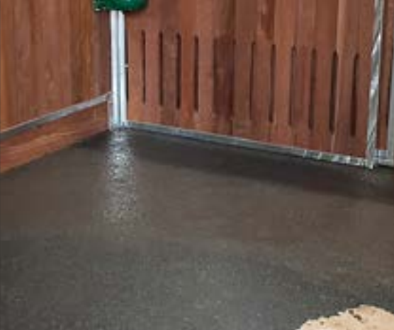
Flüssiggummi auf Betonboden
