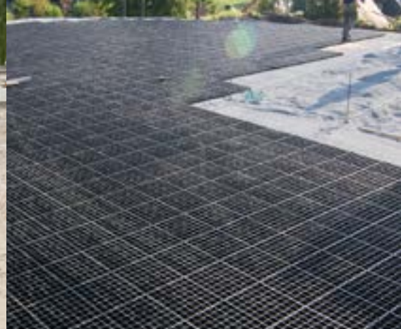
Großer Auslauf im Kreis verlegt
