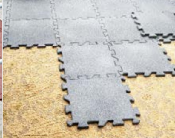
Verlegung auf Rasengittersteinen
