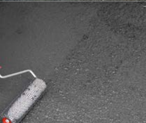
Entlüften mit der Nadelrolle
