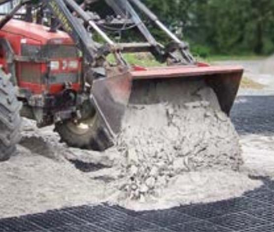
Verteilen des Sandes mit Traktor
