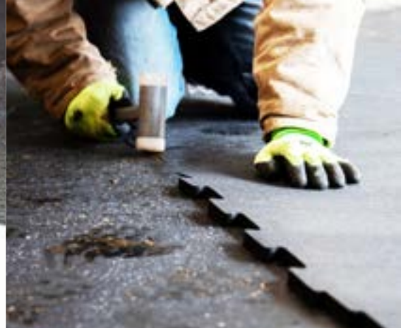
Verlegen der Matten
