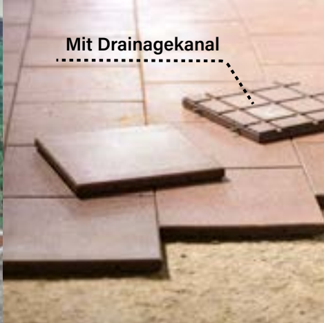
Verlegung im Versatz
