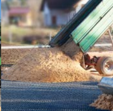
Anlieferung des Füllmaterials
