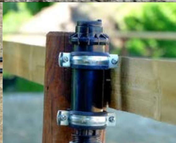
Regnerkopf am Pfosten installiert
