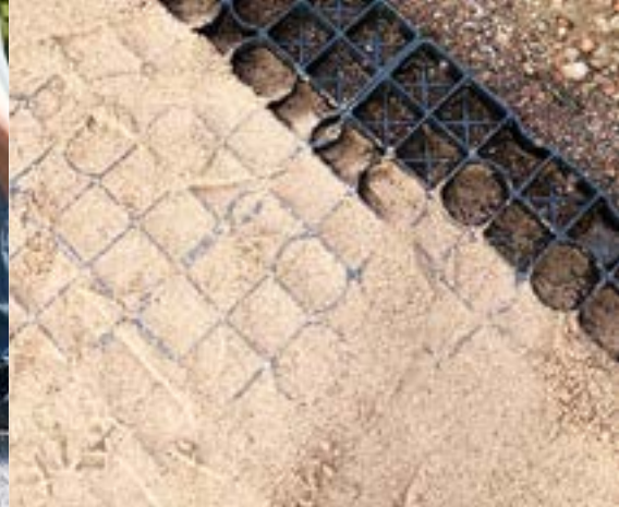
ProGrid mit Sand verfüllt
