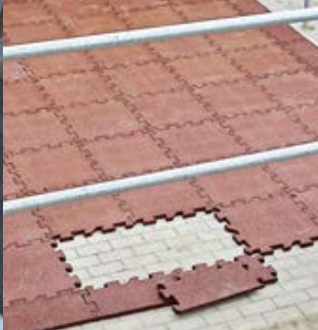
Sauber verlegt auf Pflaster
