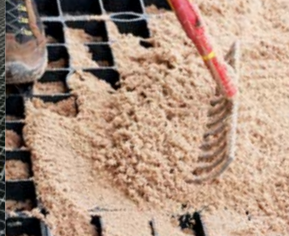
Verfüllen der Gitter
