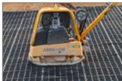
Empfohlene Rüttelplatte Gewicht: > 250 kg
