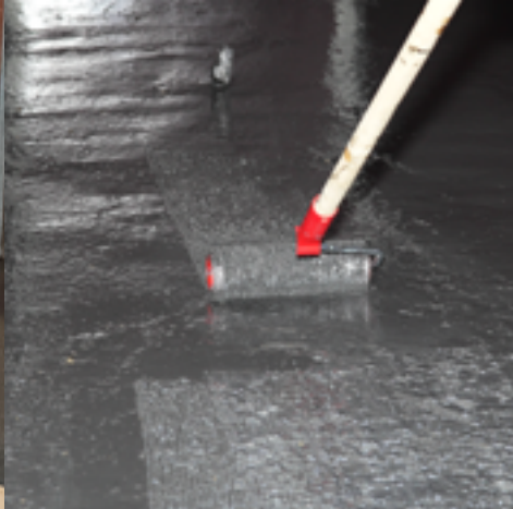
Glätten und Luftblasen entfernen
