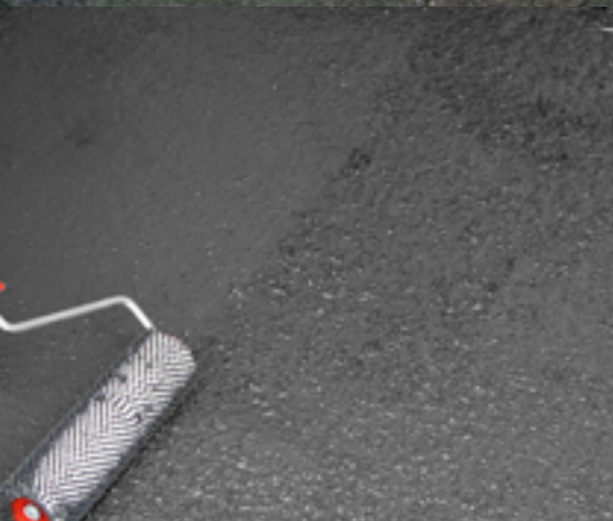
Entlüften mit der Nadelrolle
