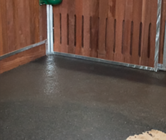
Flüssiggummi auf Betonboden
