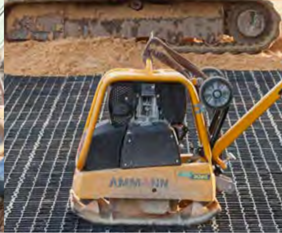
Abrütteln vor der Verfüllung
