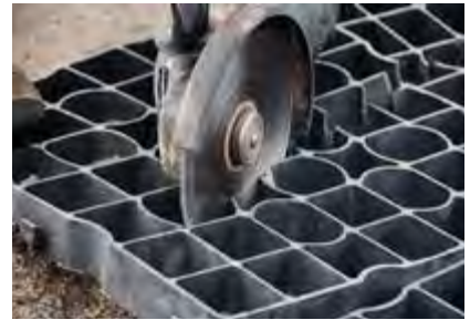
Die ProGrid können Sie sehr exakt und einfach mit einer Stichsäge, Handkreissäge oder einer Flex mit Trennscheibe zuschneiden.
