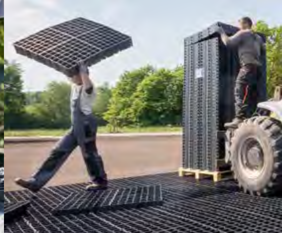
Verteilen der Progrid
