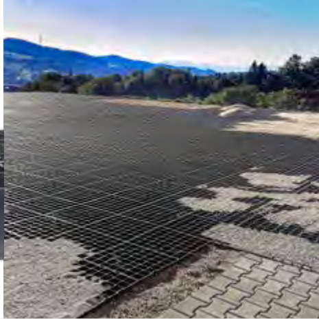
Progrid auf Splittbett
