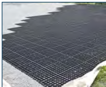
Reitplatz. Wiese mit Gefälle geebnet, Vlies + Kies + Progrid RG30
