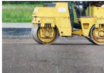
Bei Bedarf kann die Fläche auch nach dem Verfüllen der ProGrid abgewalzt werden. Die ProGrid sind für solche Belastungen gebaut.
