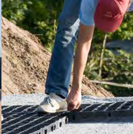
Verlegen der Lagen
