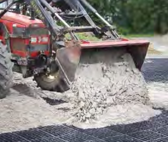
Verteilen des Sandes mit Traktor
