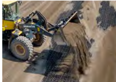
Verteilen des Füllmaterials mit einem Radlader. Hier wird Lavamaterial zur besseren Wasserspeicherung verwendet.
