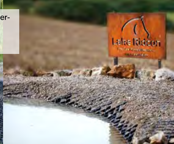
Befestigung eines Teiches
