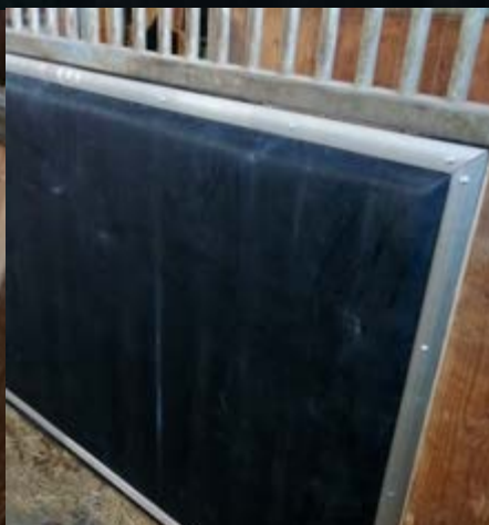
Deckbahn mit Aluleiste
