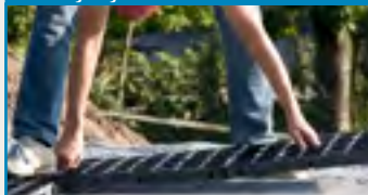
Verlegung der Pro Grid ®
