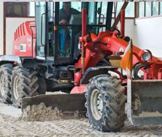
Verteilen der Tretschicht
