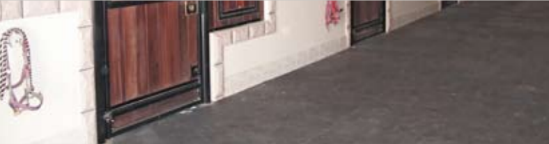
Stallgasse vollflächig verklebt: fugenlos und praktisch
