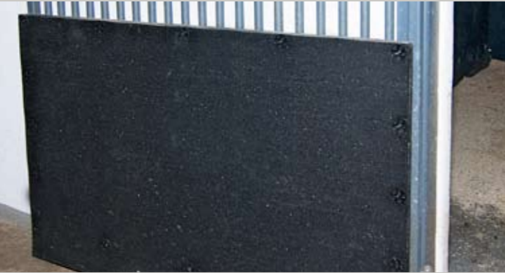
Schlagschutz an der Boxentür: guter Schutz für Pferd und Tür
