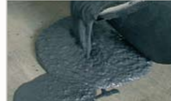
Auftragen des Flüssiggummis
