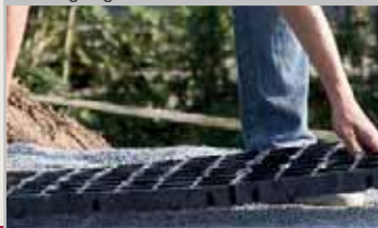
Verlegung der Pro Grid ®
