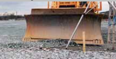
Untergrund und Unterbau vorbereiten
