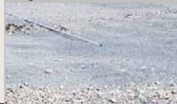
Ausgleichschicht abziehen
